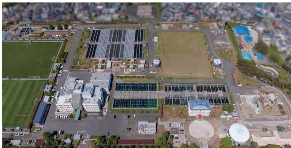
西谷浄水場(再整備事業前)
