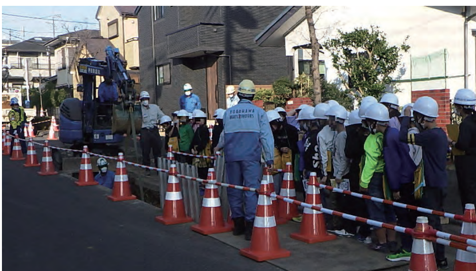
工事現場見学会の様子
