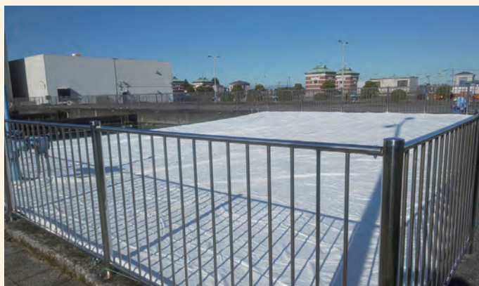
建築用養生シート設置後の様子
