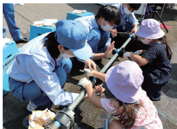
イベントでの漏水修理体験
